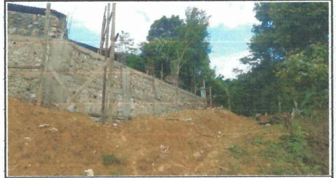
Foto 4: Finalización de la activación de muro perimetral, teniendo una altura de 7 metros la parte frontal derecha y un largo de 60 metros. La parte trasera tiene una altura 6 metros y de largo 15 metros.
