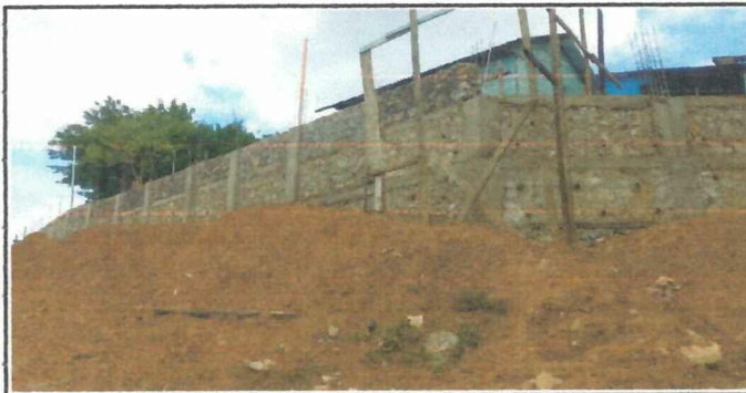
Foto 5: Finalización de la activación de muro perimetral, teniendo una altura de 7 metros la parte frontal derecha y un largo de 60 metros. La parte trasera tiene una altura 6 metros y de largo 15 metros.
