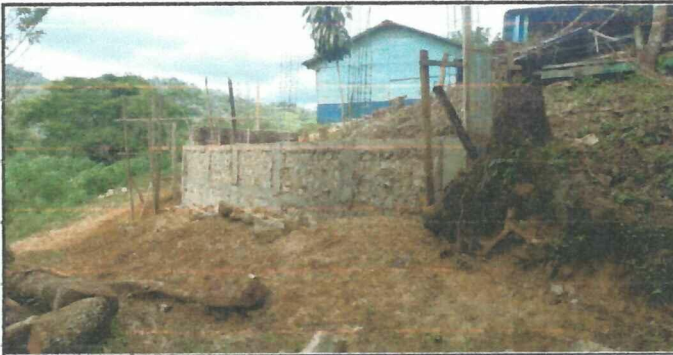
Foto 3: Finalización de la activación de muro perimetral, teniendo una altura de 7 metros la parte frontal derecha y un largo de 60 metros. La parte trasera tiene una altura 6 metros y de largo 15 metros.
