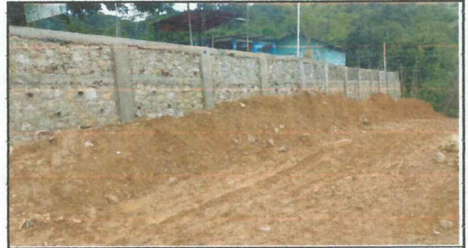
Foto 6: Finalización de la activación de muro perimetral, teniendo una altura de 7 metros la parte frontal derecha y un largo de 60 metros. La parte trasera tiene una altura 6 metros y de largo 15 metros.
