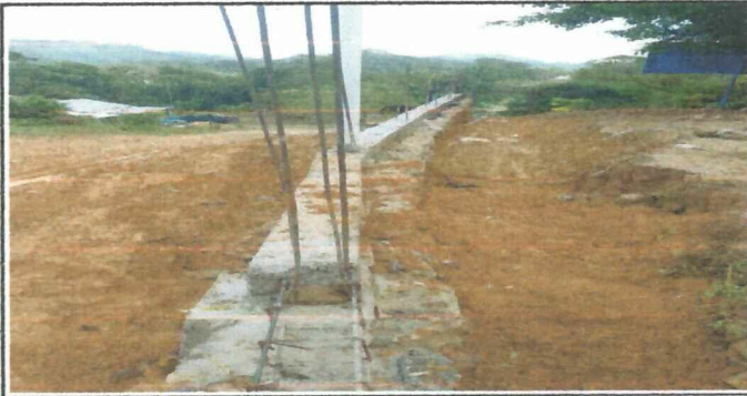
Foto 1: Finalización de la activación de muro perimetral, teniendo una altura de 7 metros la parte frontal derecha y un largo de 60 metros. La parte trasera tiene una altura 6 metros y de largo 15 metros.
